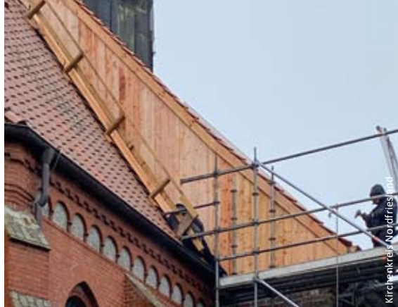
St. Marien-Kirche in Witzwort. Links: Die Südfassade ist eingerüstet; rechts: Die Giebelbekleidung am Kirchenschiff wurde erneuert.
