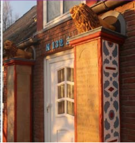
Heute erscheint der Eingang in seiner neuen Pracht.
